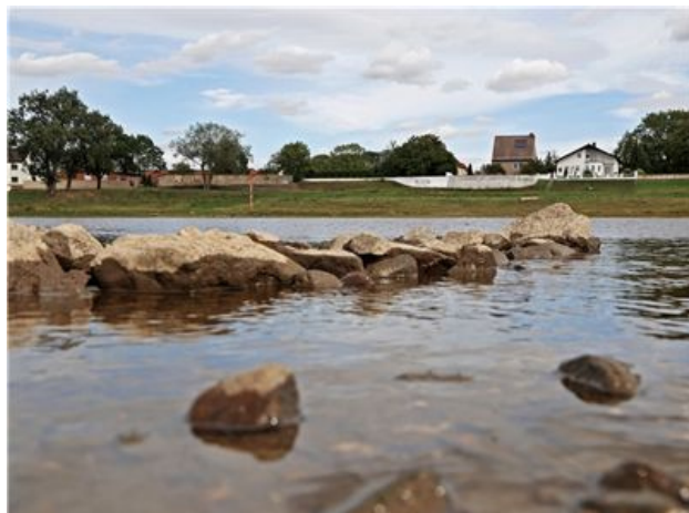
Zurzeit ist die Elbe ungefährlich – doch das Hochwasser hat die Gemeinde Nünchritz 2002 und 2013 schwer getroffen. Der Ausbau der Deichlinie aber lässt weiter auf sich warten.
